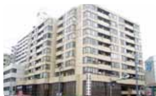
◎堺町 COOP マンション
