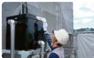
◎補給水槽下塗り状況
