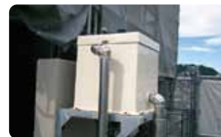
◎補給水槽塗装完了
