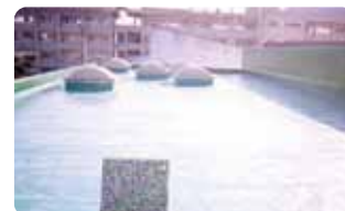
◎屋上防水工事
