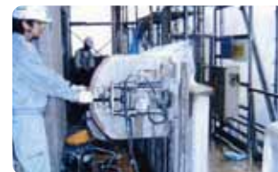
◎コンクリート切断工
